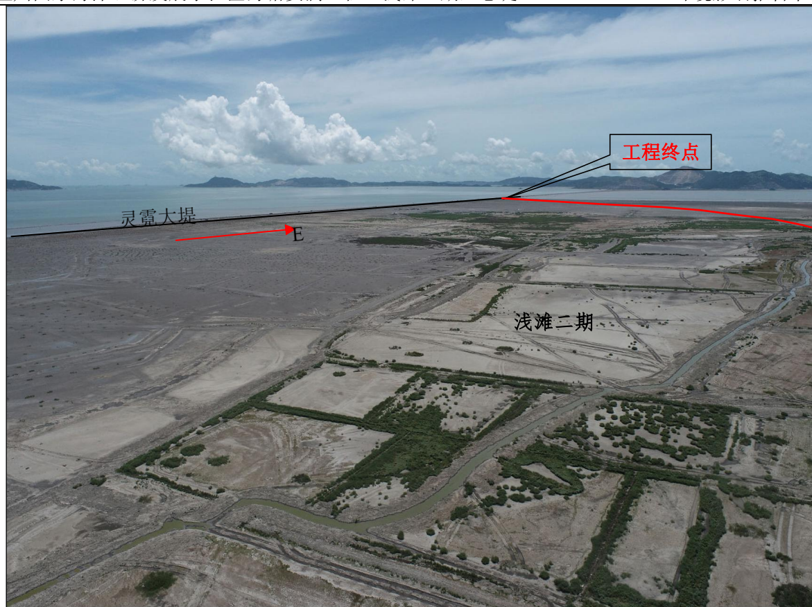
图 3.1-5 工程所在区域现状
